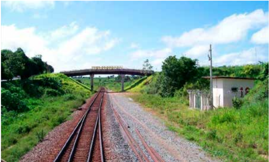
Trecho da Estrada de Ferro Carajás, os 892 quilômetros de trilhos que ligam as minas do Pará ao terminal de Ponta da Madeira, no Maranhão. A logística própria é a segunda fonte de renda diferencial
